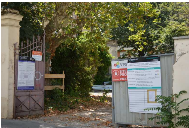
Des travaux sont en cours dans cet ancien squat de Lyon amené à accueillir un projet d'hébergement solidaire. Photo : MP/Rue89Lyon
