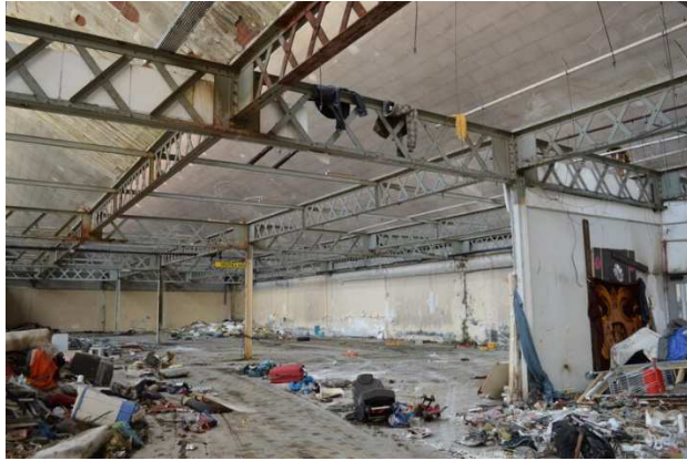
La pièce principale de l'ancienne quincaillerie, occupée pendant près de deux ans. Photo : MP/Rue89Lyon
